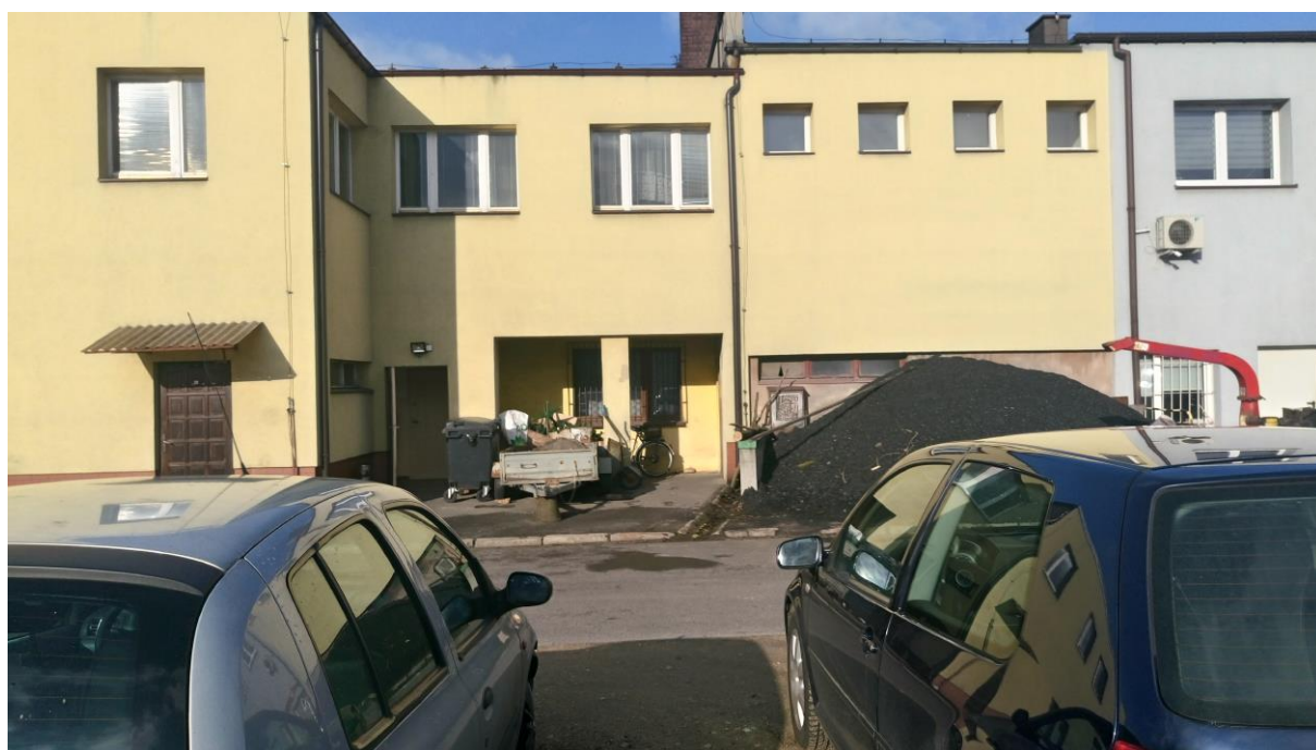
Fot. 4-Elewacja wschodnia
