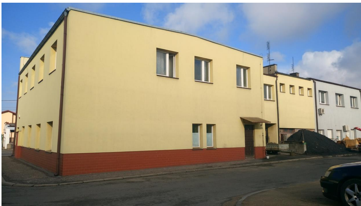
Fot.6-Widok na elewację wschodnią i południową
